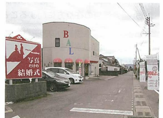
雨水整備（札元1丁目地区）
