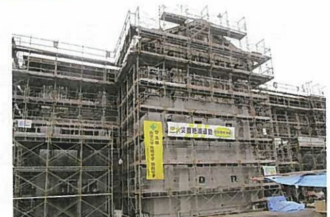
鹿屋東中学校校舎増設
