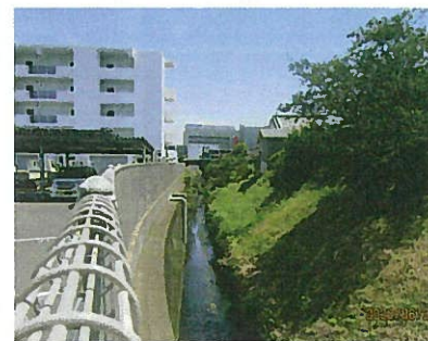
5号排水路改修工事(予定)
