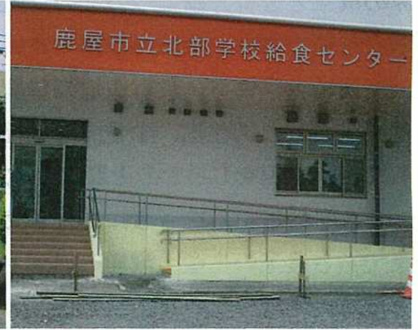
工事完了前の北部給食センター
