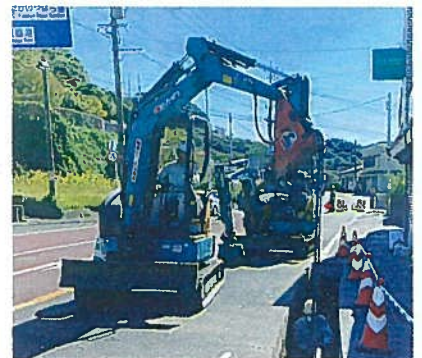
水道管路工事
