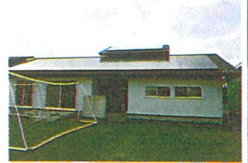
太陽光発電設備
