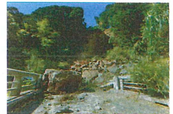
市道 一里山高牧線復旧工事
