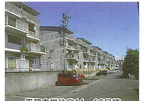
平和市営住宅11～13号棟
