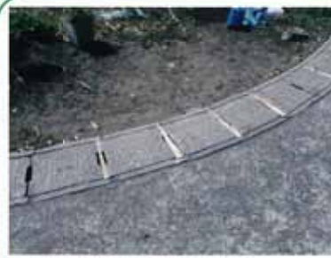
〔通学路危険箇所改修〕 住宅地の造成工事のため、 通学路が一時変更になり、 側溝に隙間があり危険なため 改修。（市道ではありません）
