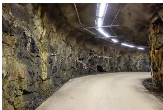
(岩盤がむき出しの通路)
